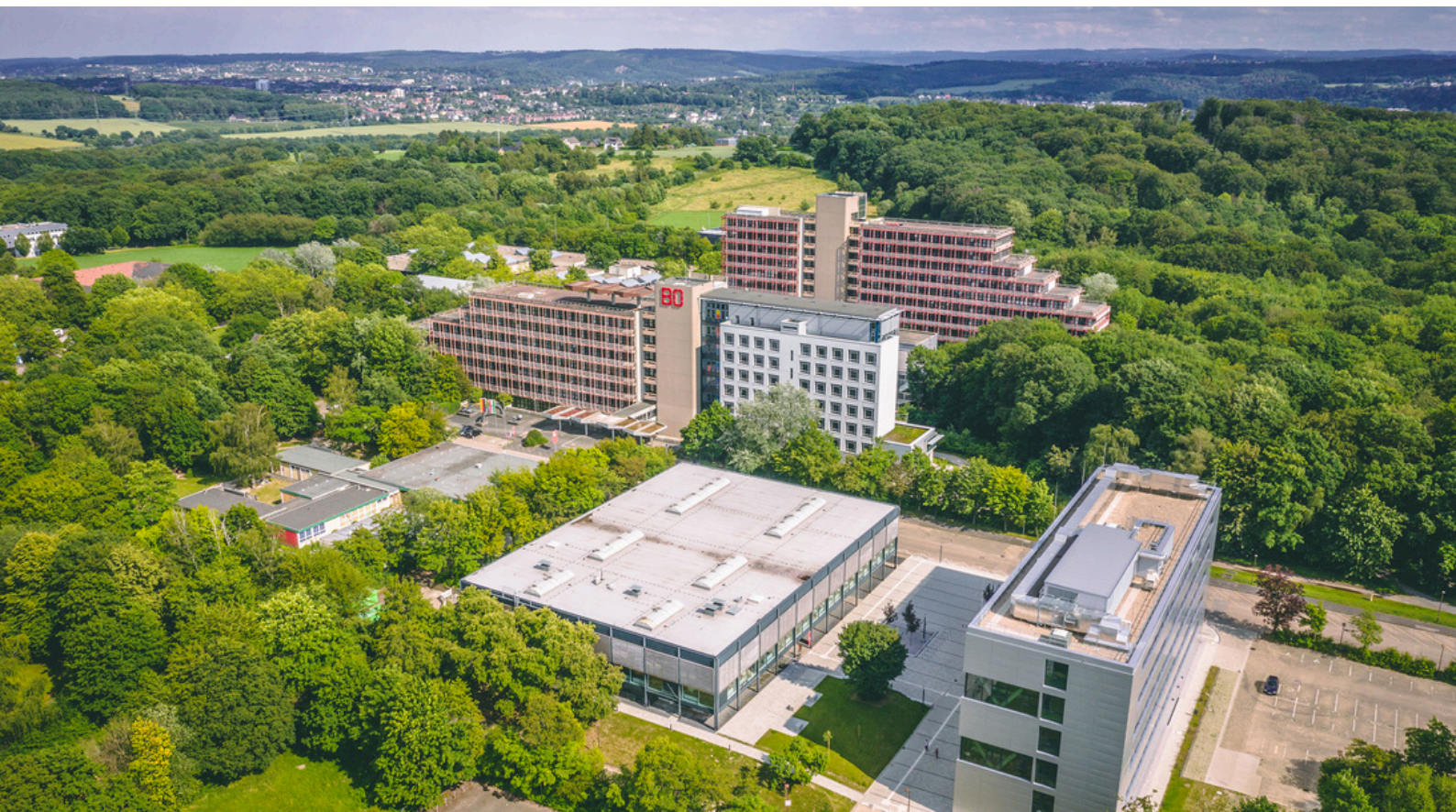
Abbildung 3: Gesamtansicht des Zentralcampus der Hochschule Bochum
