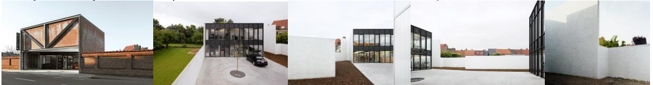
Computer Shop 2007-2009 (OFFICE Kersten Geers David Van Severen)
